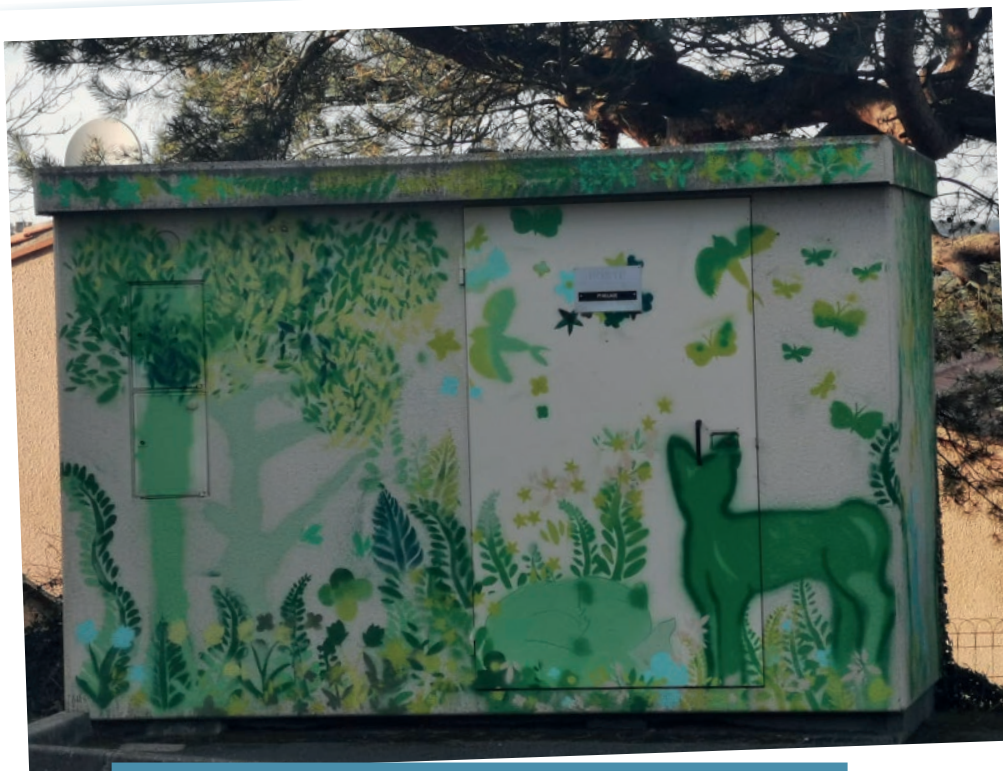
Habillage du transformateur lors d'un chantier jeune. Remerciements à Gérald CALLIER pour son aide.
